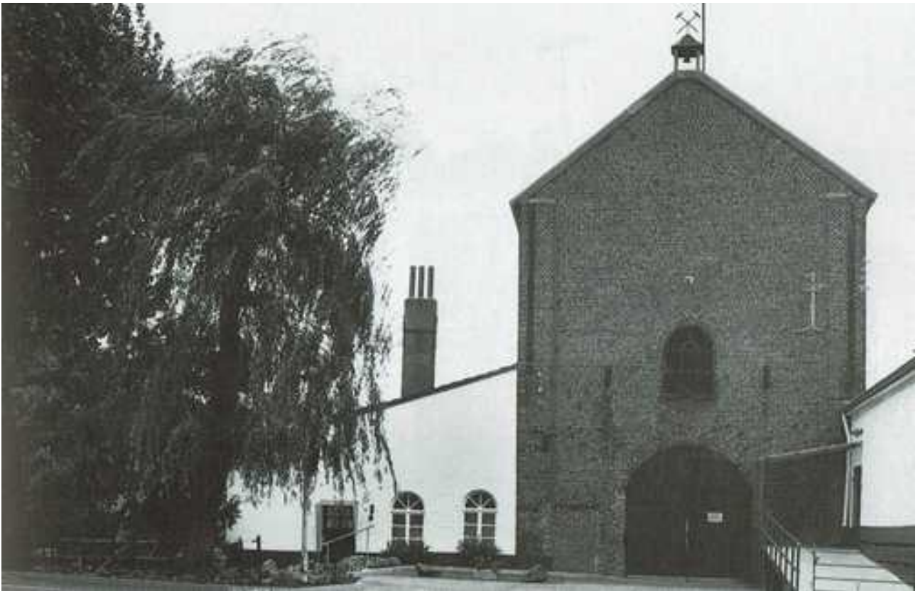
Die Schachtanlage der Grube Langenberg vor dem Teilabriss 1995
